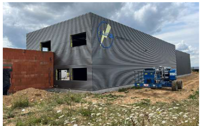
Travaux des futurs locaux de la société BEVELEC
