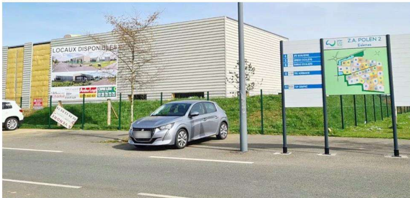
Plusieurs bâtiments sont actuellement en construction sur la zone d'activité Polen 2 qui appartient à la communauté de communes Inter Caux Vexin
