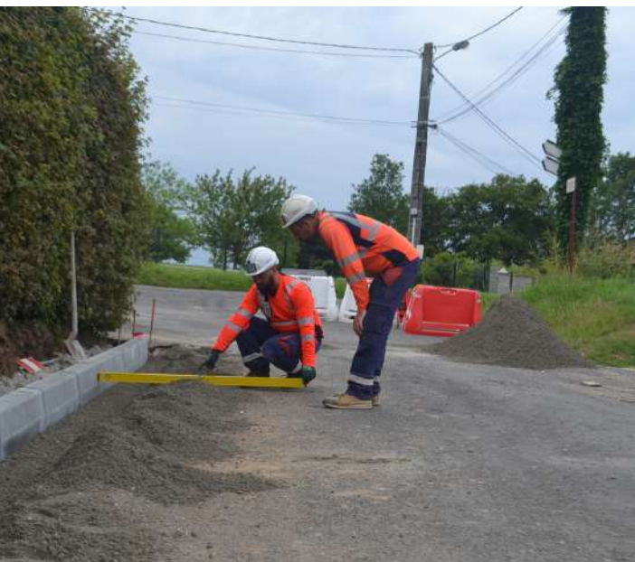
Travaux de bordurage sur la commune de Sierville
