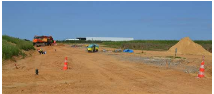
Démarrage des travaux de la tranche 2 sur la ZAE Polen 2
